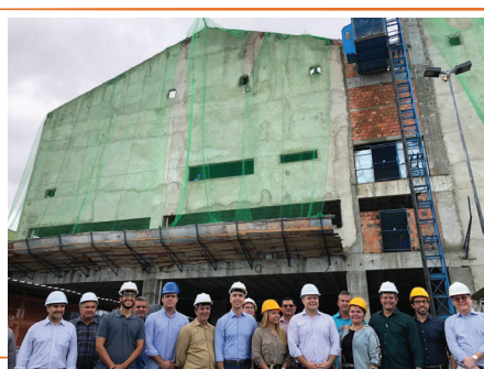
VISITA À OBRA DE AMPLIAÇÃO DO CENTRO DE CONVENÇÕES
